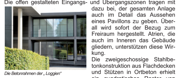
Die Betonrahmen der „Loggien“
