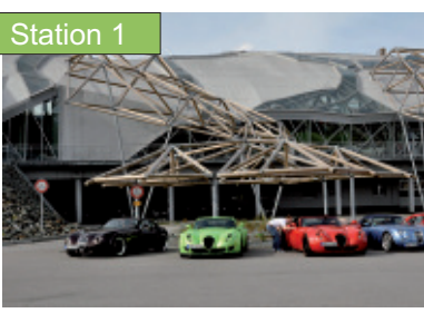
Firmengebäude Wiesmannmanufaktur, Dülmen
